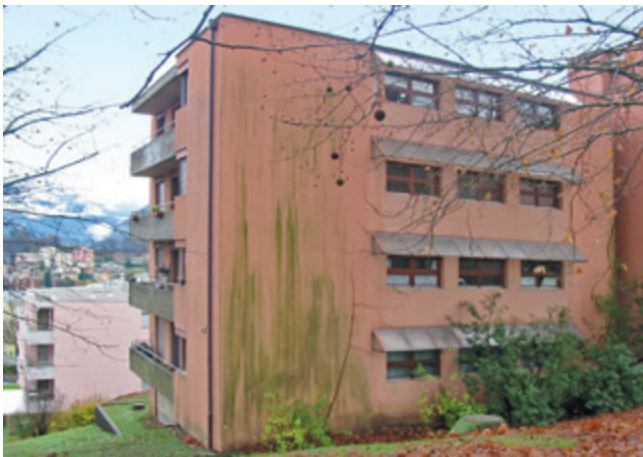
Der fehlende Dachvorsprung begünstigt den Bewuchs.
