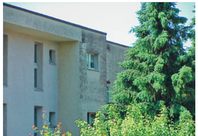
Durch Schattenwurf trocknet die Fassade nur langsam ab.
