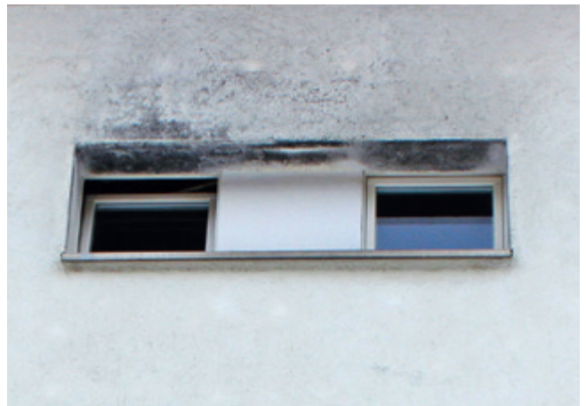
Typisches Schadensbild (Dauerlüfter).
